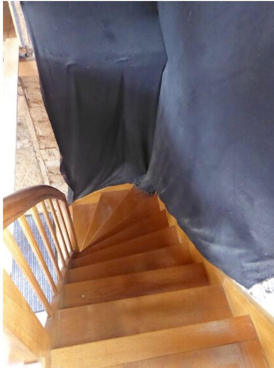
Offene Treppe ins OG
