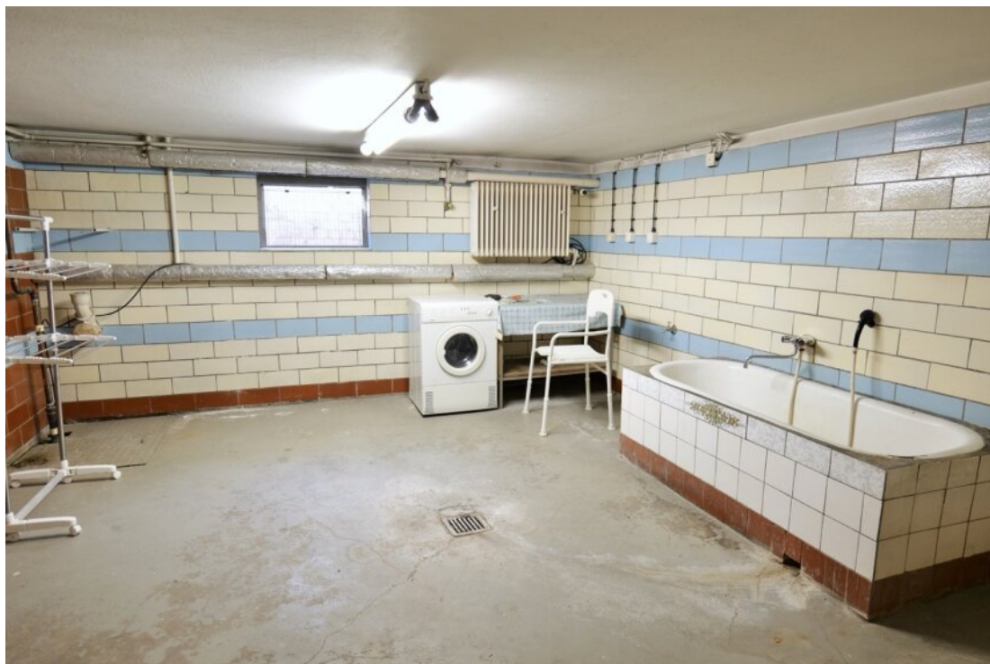
Waschraum im Keller
