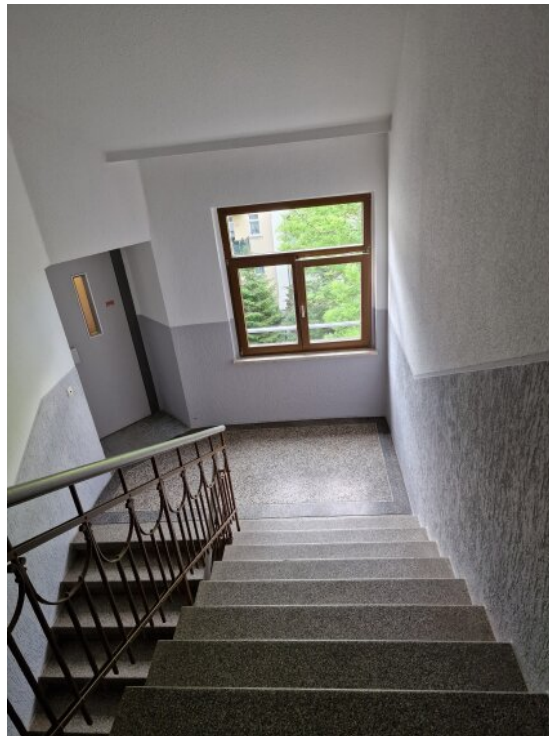
Treppenhaus mit Fahrstuhl
