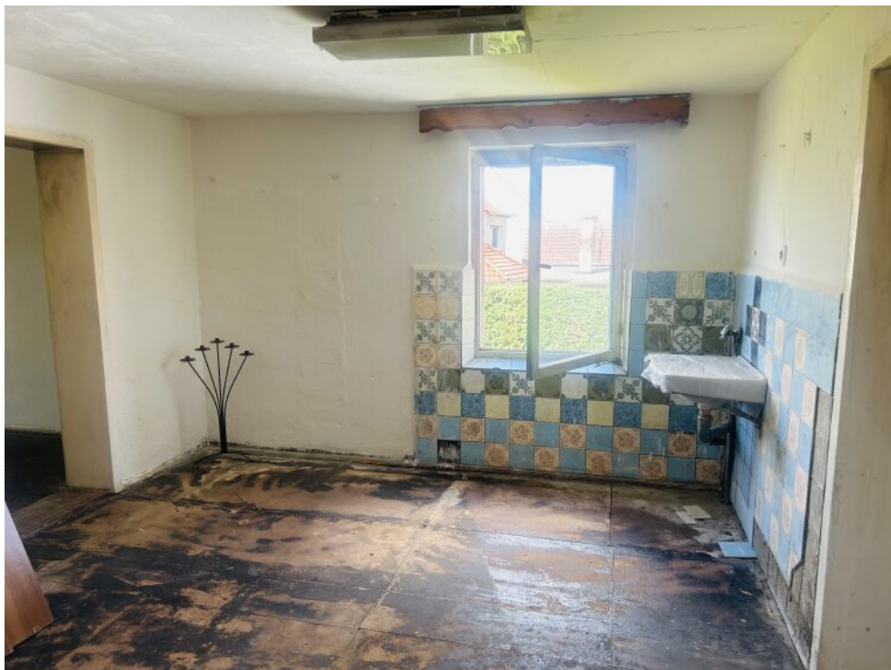
Haupthaus Bad 1.OG
