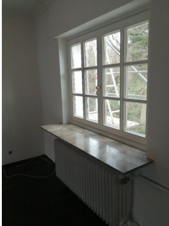
Fenster Wohnzimmer OG
