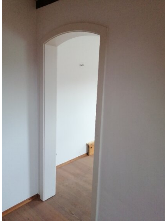
Durchgang Schlafzimmer Dachgeschoss
