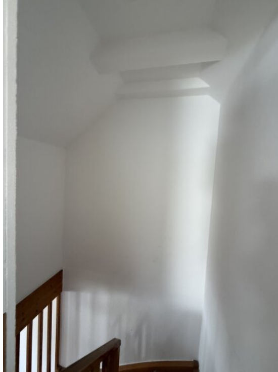
Firsthohe Ausf. Treppenaufgang
