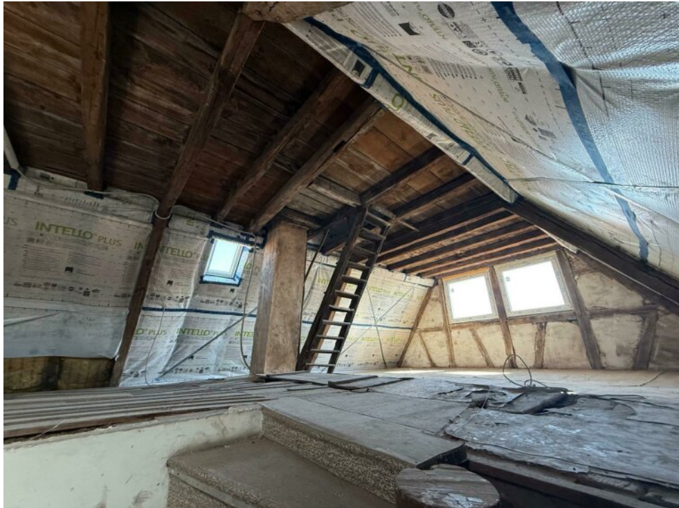
gedämmter, ausbaubarer Dachboden
