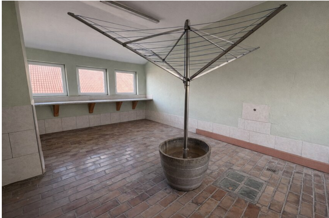
Neubau Dachraum 2006 mit Kaminanschluss
