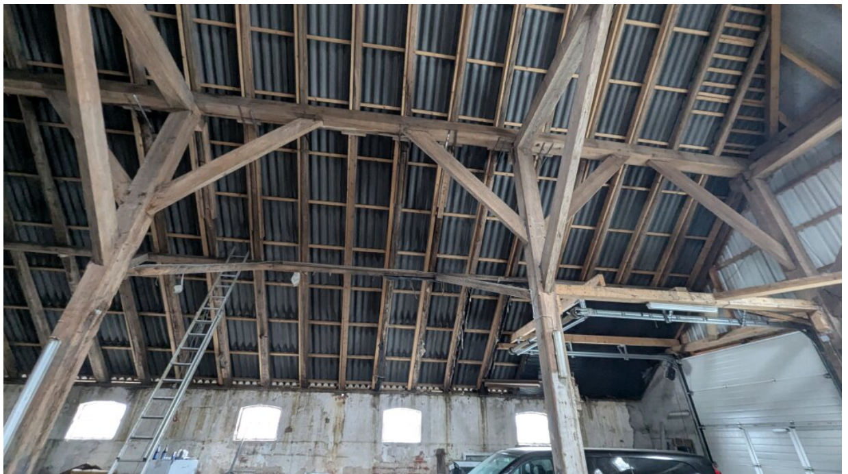
erneuertes Dach, Giebelwand und Rolltore
