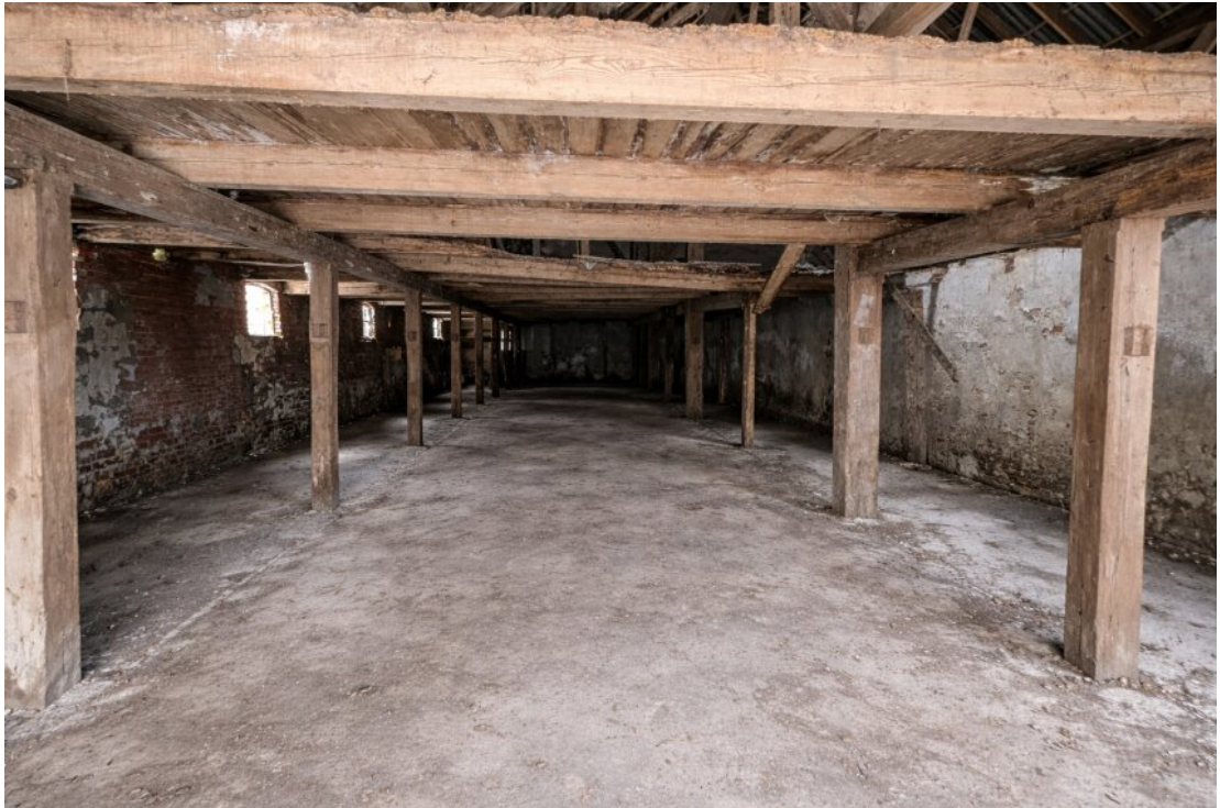
Halle linke Seite mit Zwischenboden
