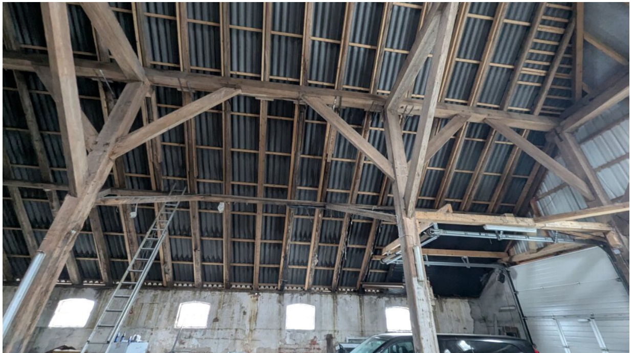
erneuertes Dach, Giebelwand und Rolltore
