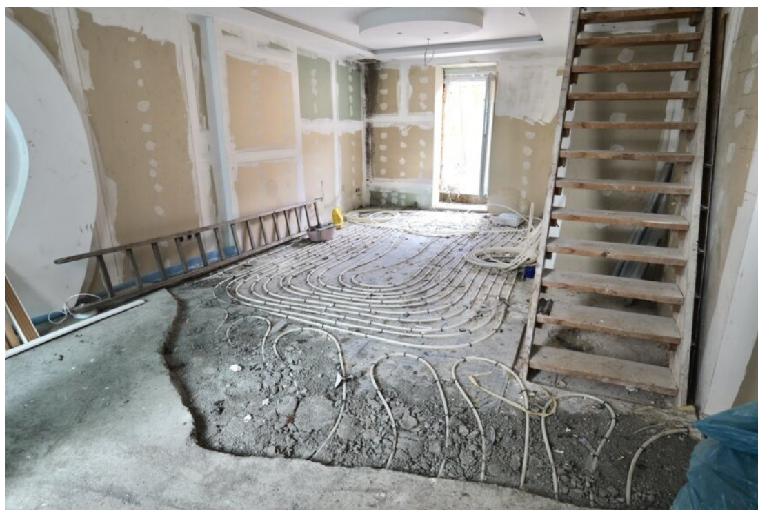
Vorbereitete Fußbodenheizung
