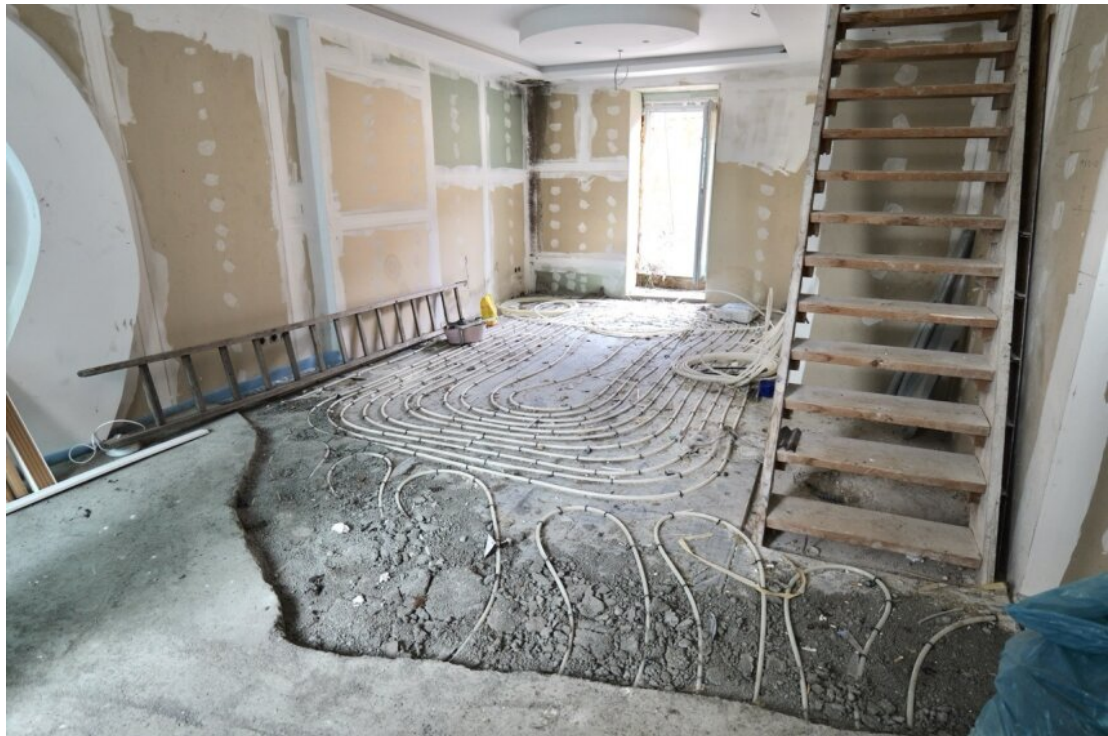
Vorbereitete Fußbodenheizung
