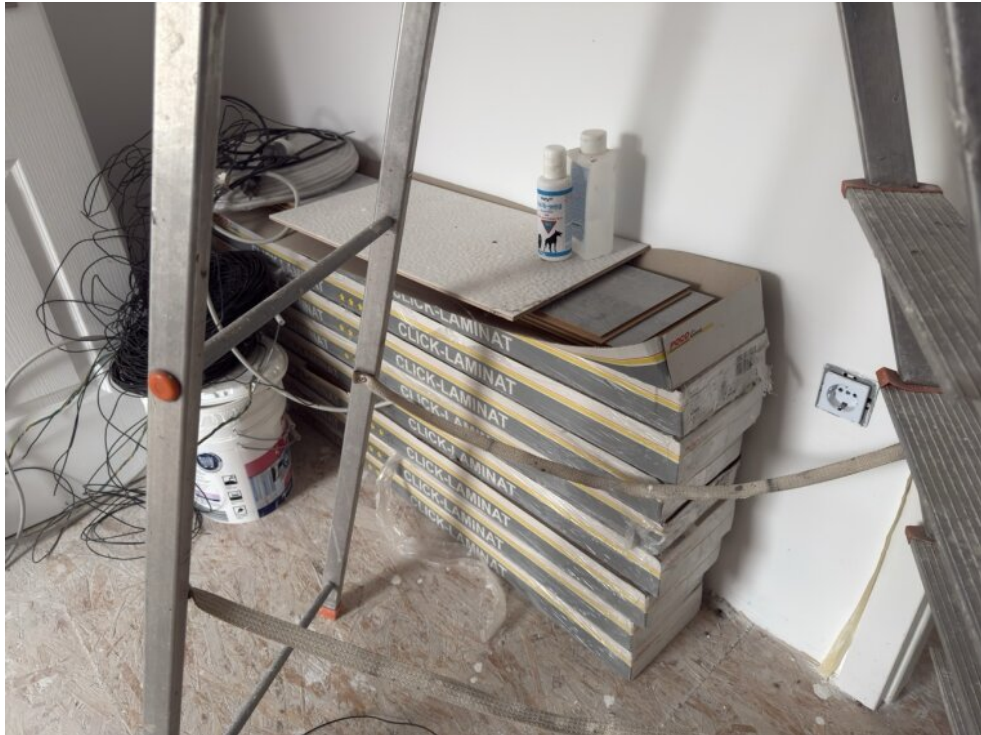
Laminat zur Verlegung im OG
