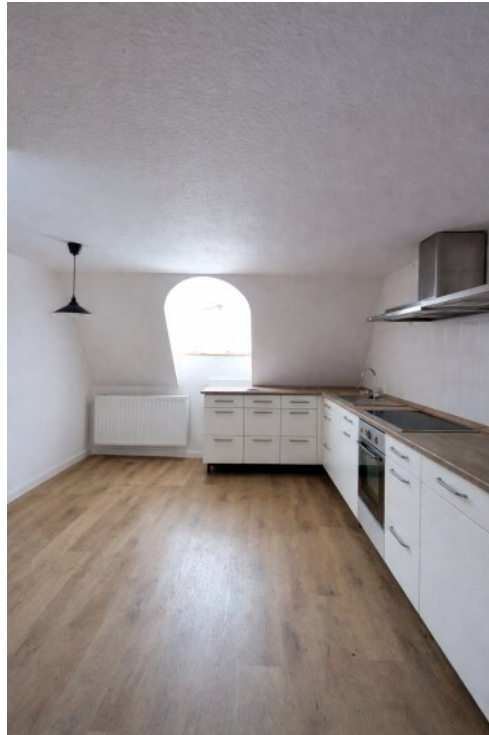
DG Whg Wohnhaus- neue Küche im Aufbau
