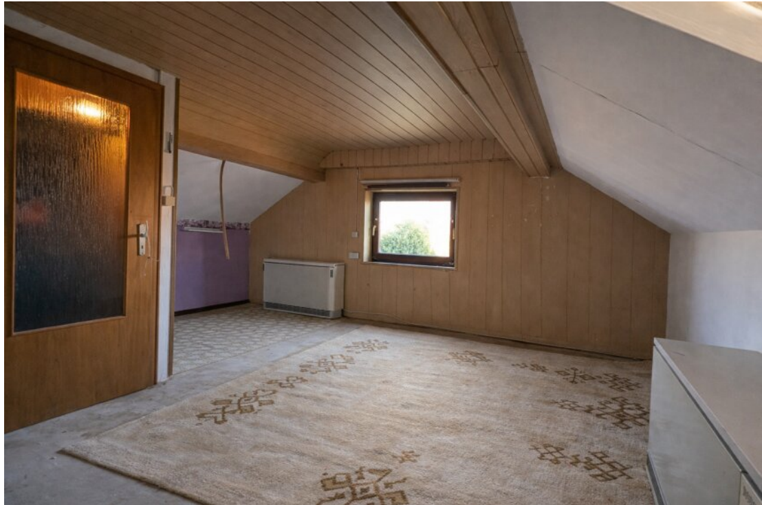
DG Dachbodenraum mit Blick zum Giebel
