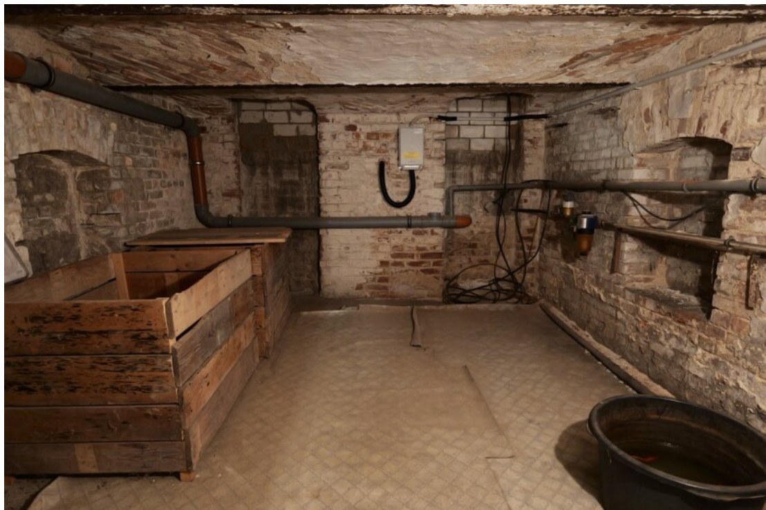
Keller mit Außenzugang
