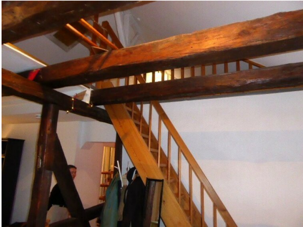
Zugang Schlafbereich 3. OG
