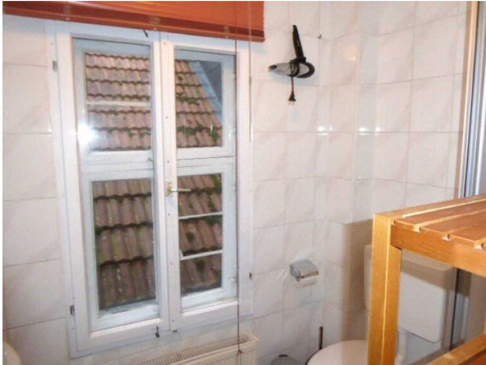
Fenster Bad 3. OG
