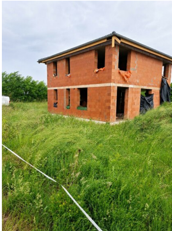
Rohbau mit Grundstück
