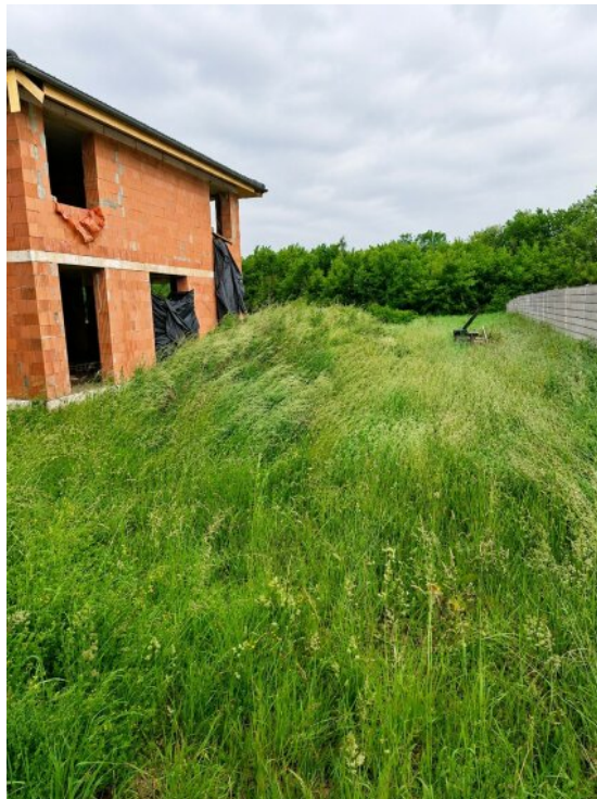
Rohbau und Grundstück 1
