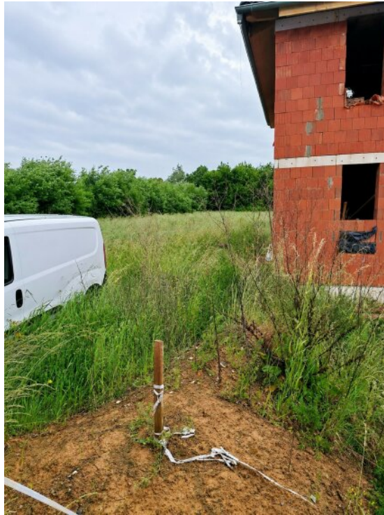
Rohbau mit Grundstück
