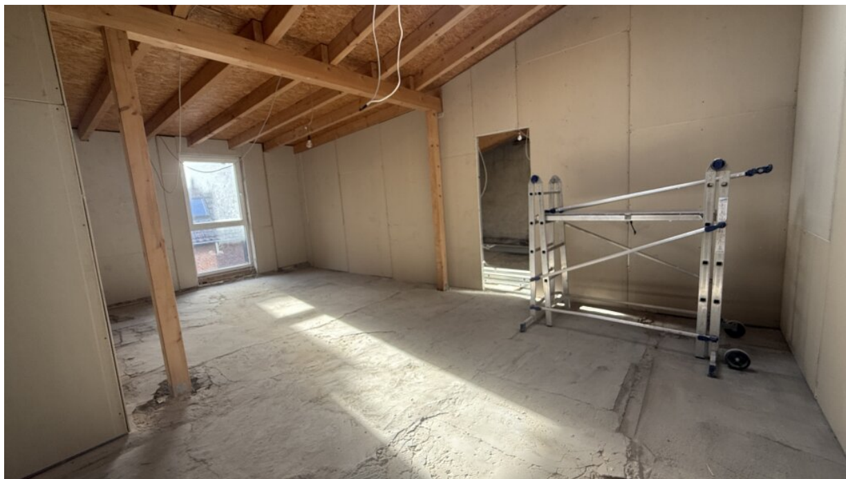
Wohnung - Rohbau - Wohnzimmer
