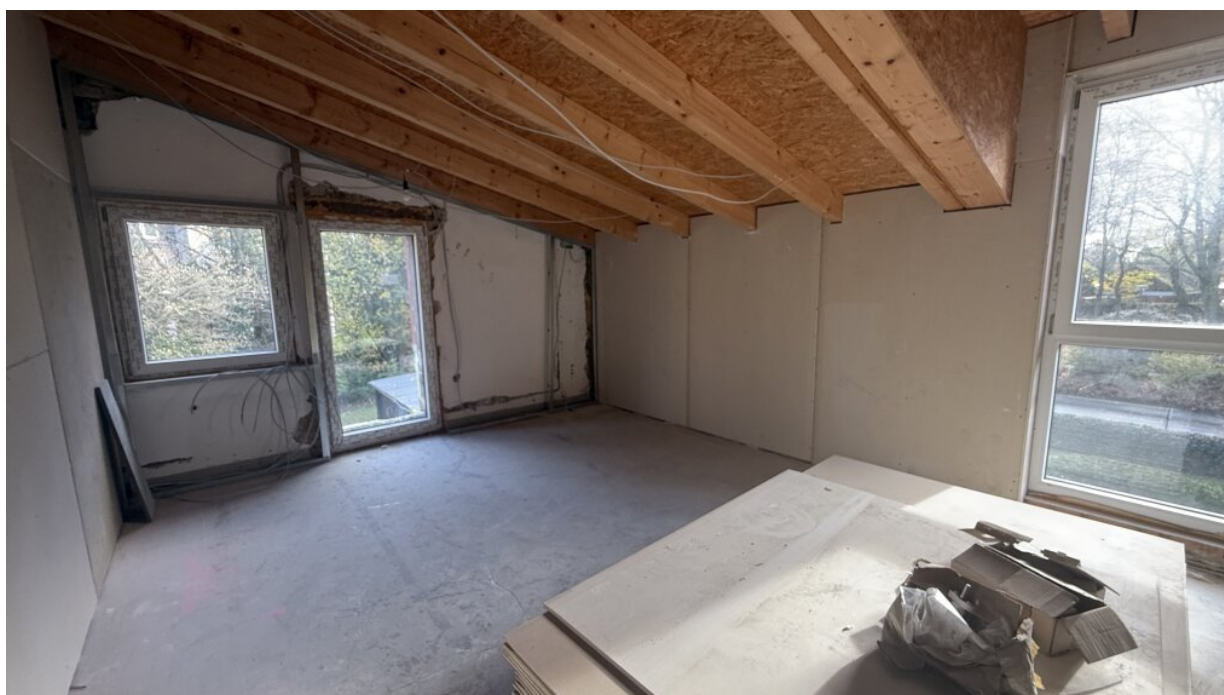
Wohnung - Rohbau - Schlafrum 1
