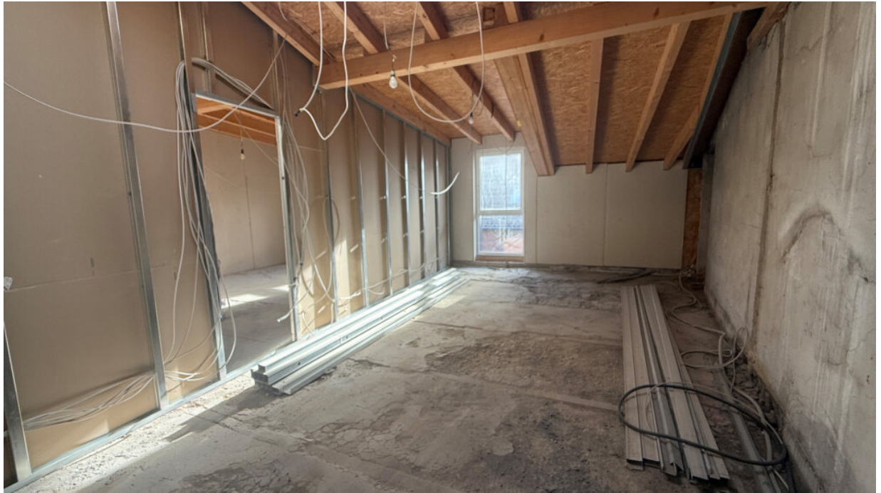
Wohnung - Rohbau - Schlafraum 2
