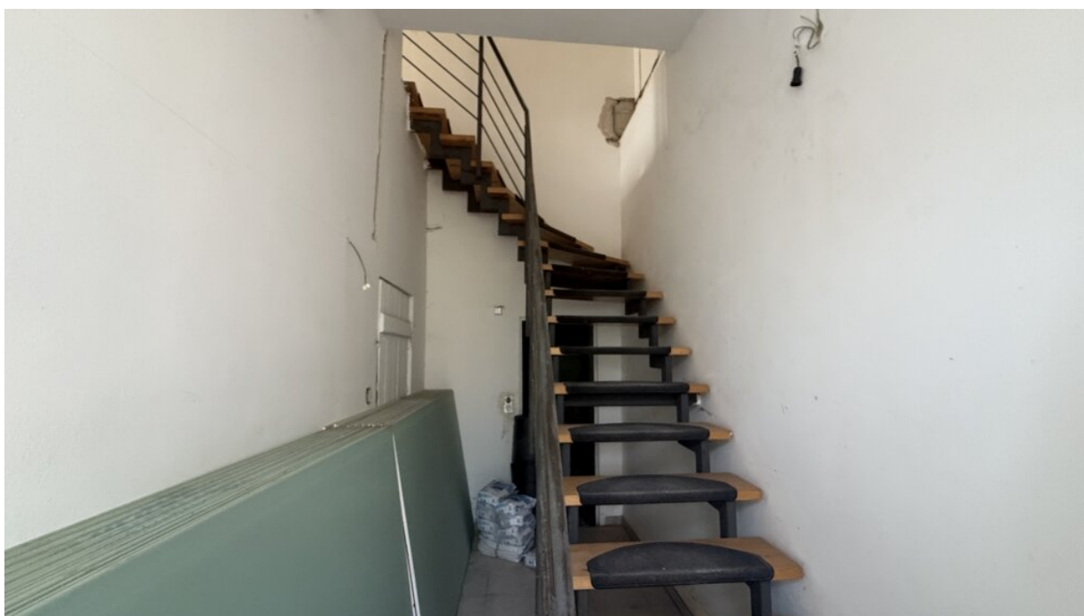
Wohnung - Rohbau - Aufgang
