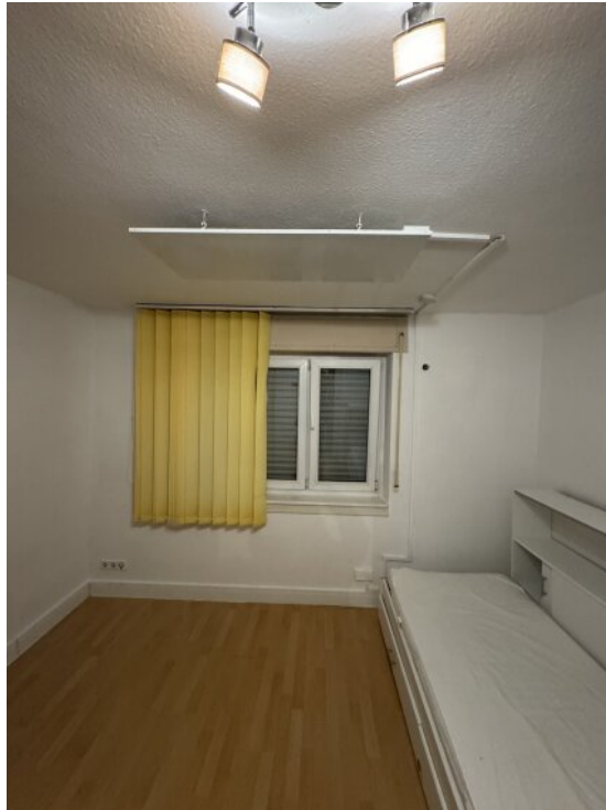
Infrarotdeckenpaneele
