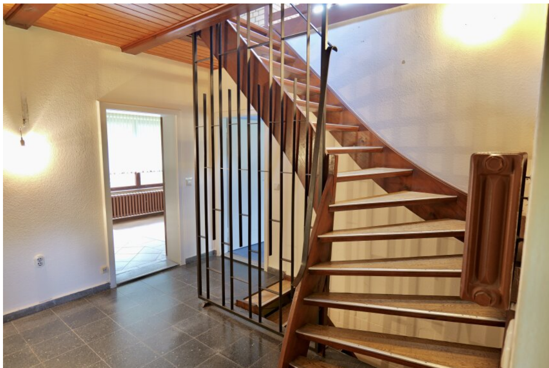
Treppe zum Atelier und Keller
