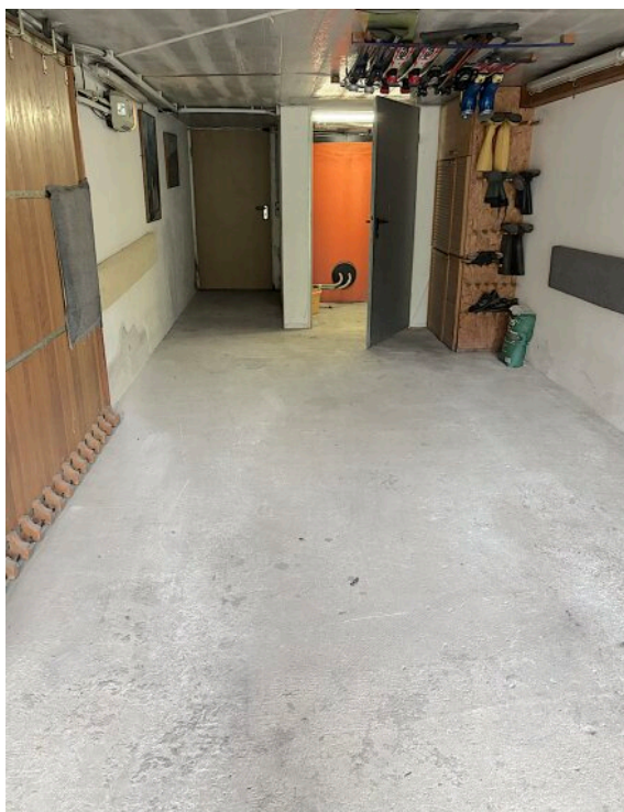
Garage mit Technikraum
