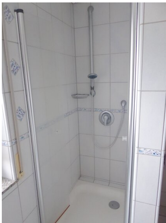
Dusche im Bad EG
