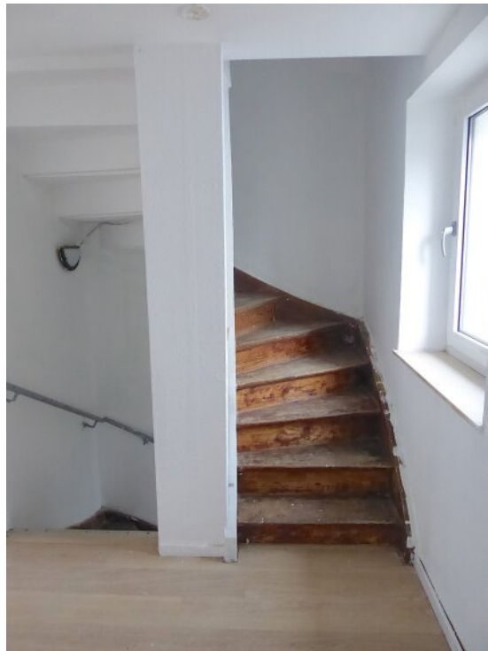
Flur mit Treppe OG
