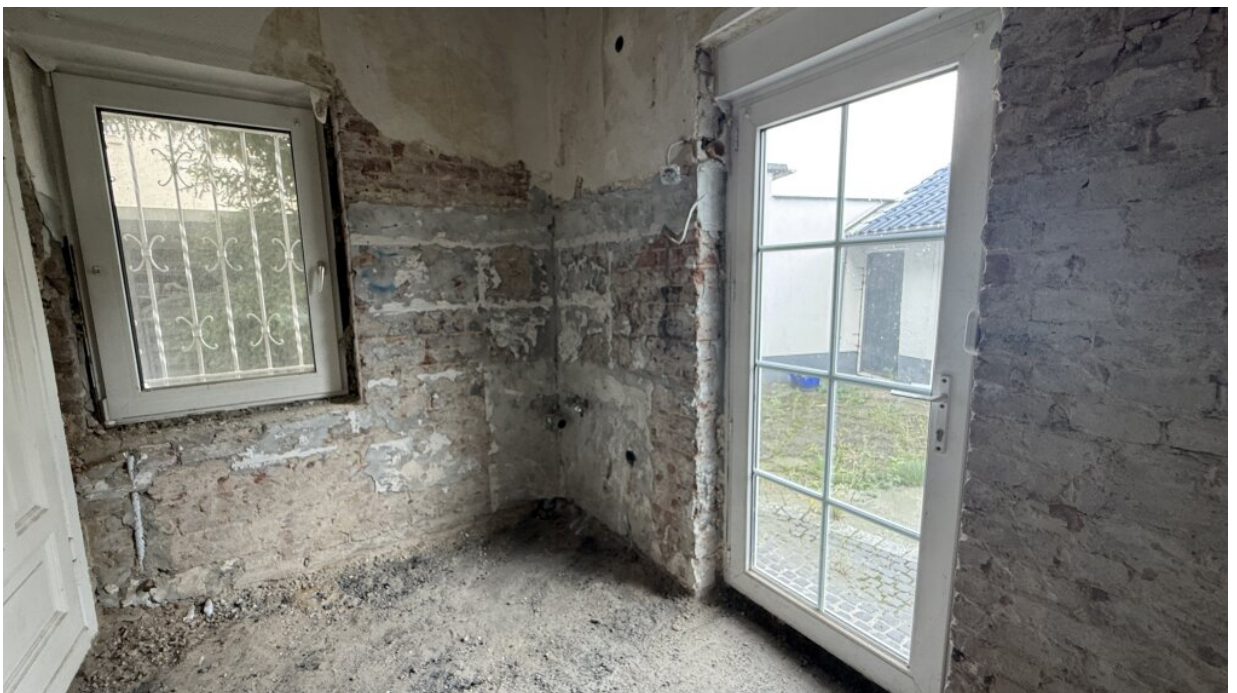
EG - Eingang Keller - Ausgang Garten
