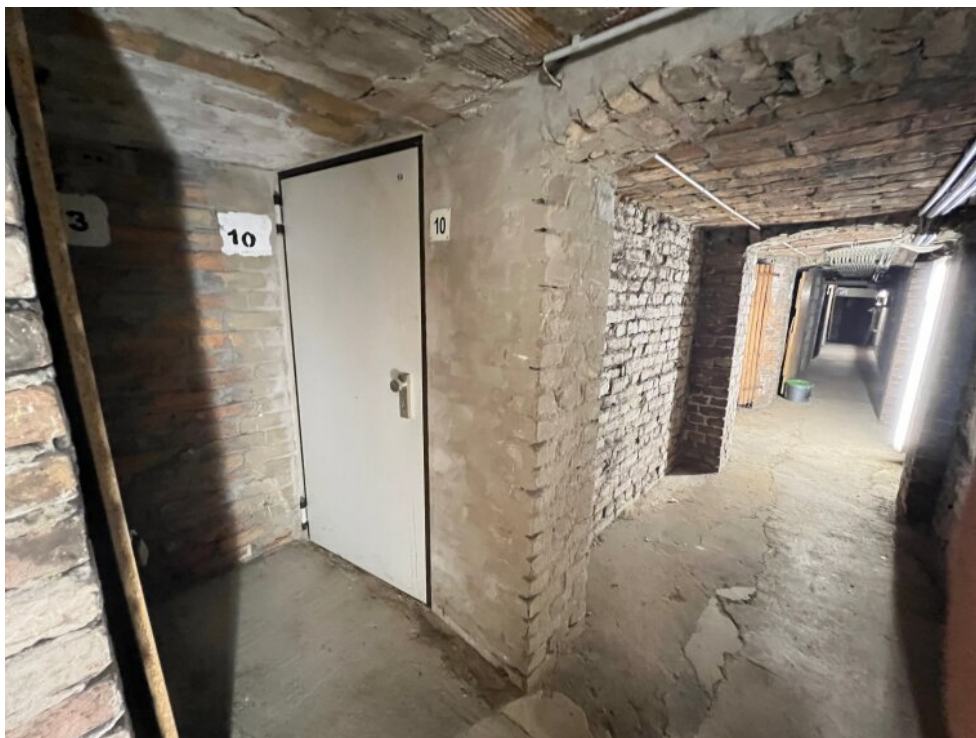
Kellerabteil mit sicherer Tür
