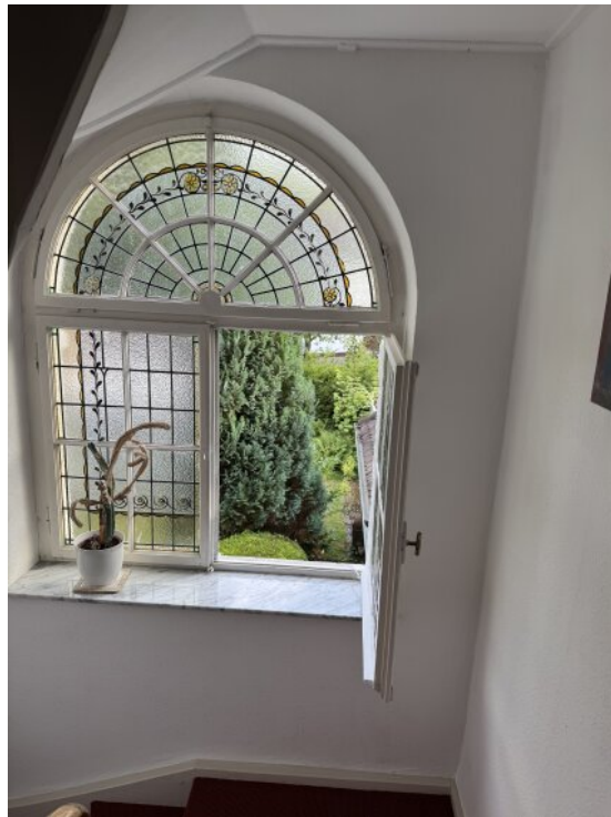
Fenster im Treppenhaus
