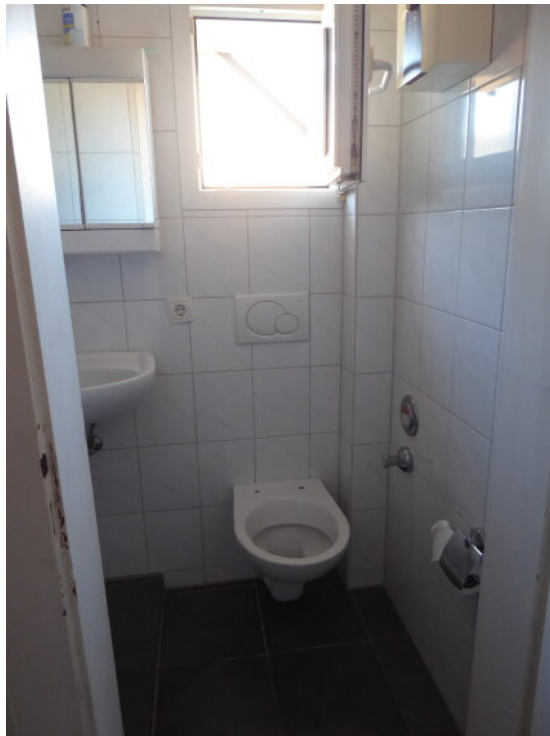
Tageslicht Duschbad DG
