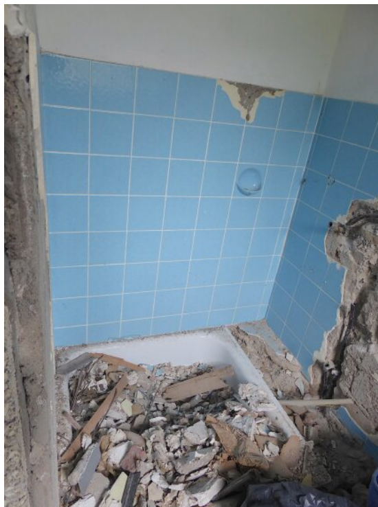
Duschbad im Anbau
