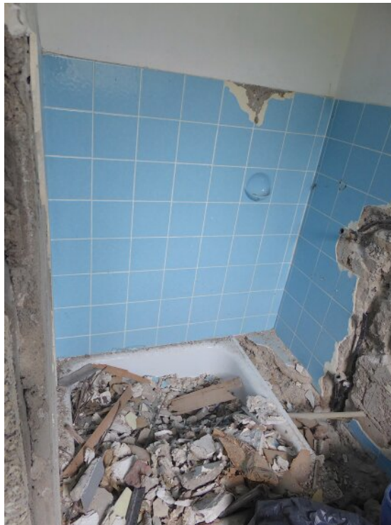
Duschbad im Anbau
