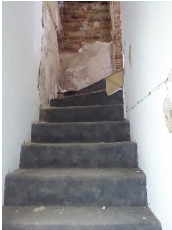
Treppe zum OG
