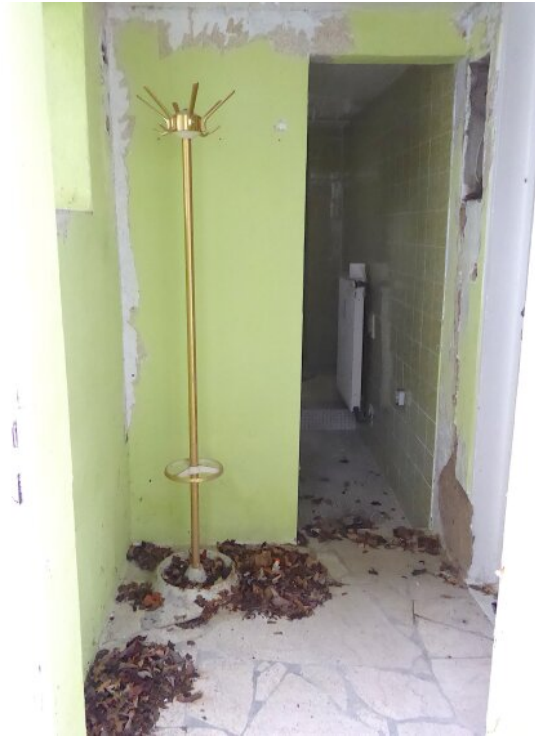
Eingangsbereich Wohnung vorne
