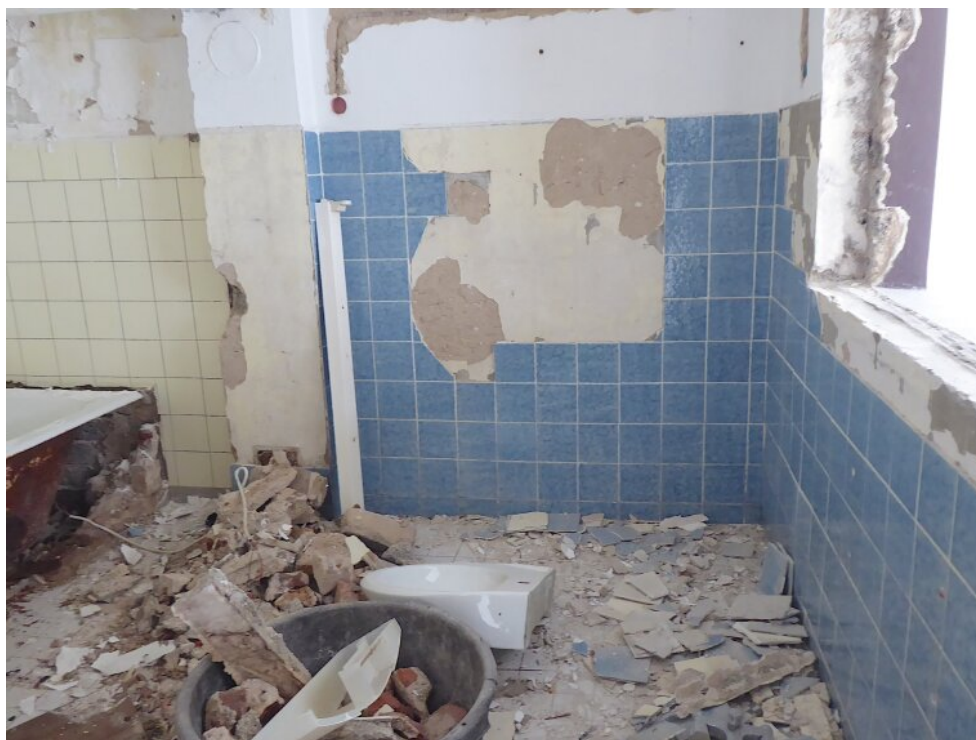
Tageslichtbad EG vorne
