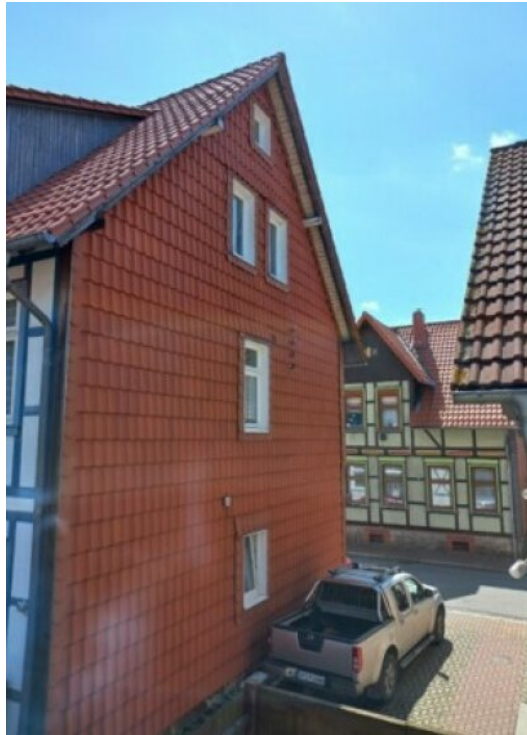
Giebel_Blick zur Strasse
