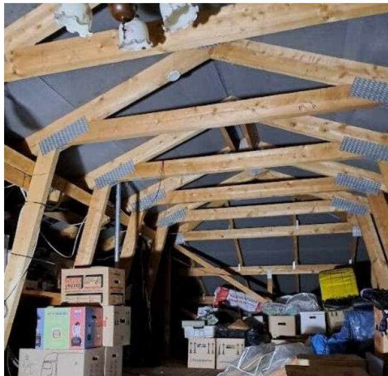
Gedämmter Dachboden, ausbaubar
