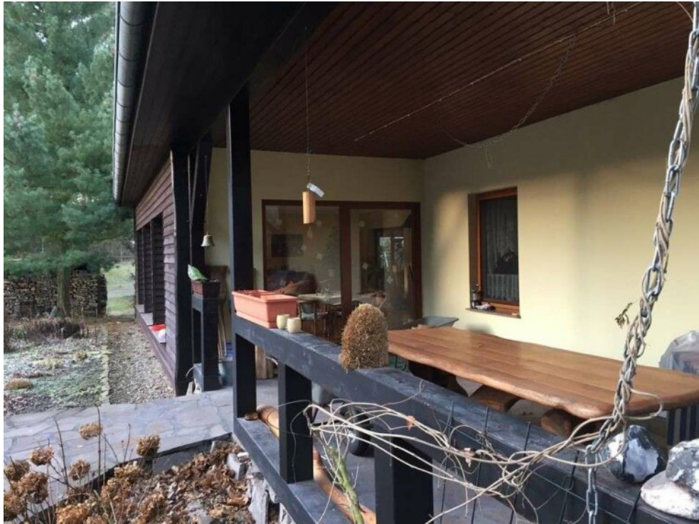
Terrasse/ Zugang Wohnzimmer
