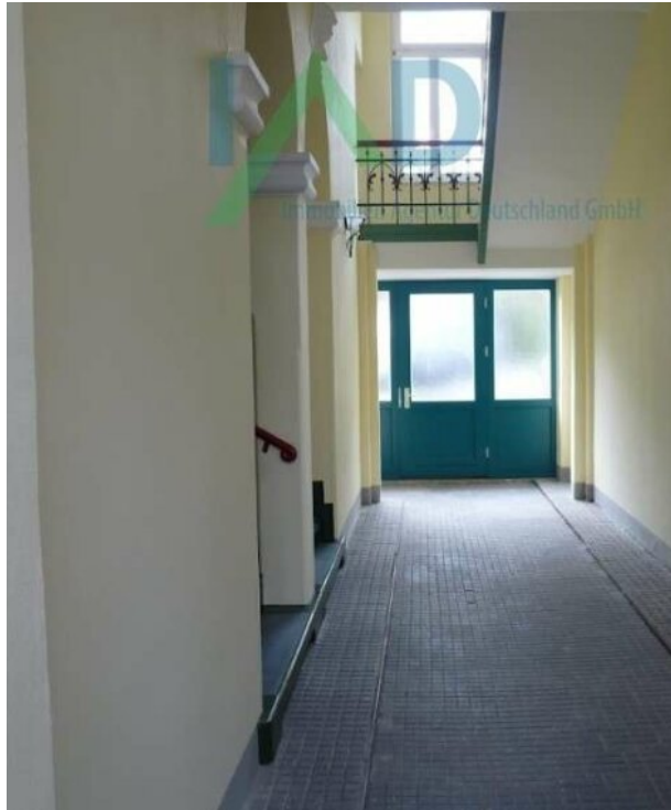
Durchgang im Treppenhaus
