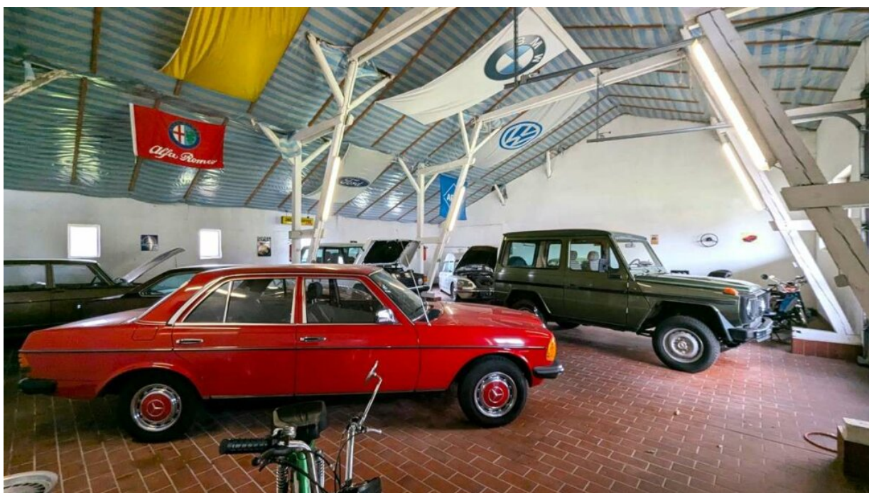
sanierte Halle 2- Ausstellraum
