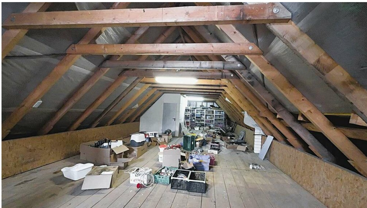
Halle 1 Dachboden- Lagerfläche
