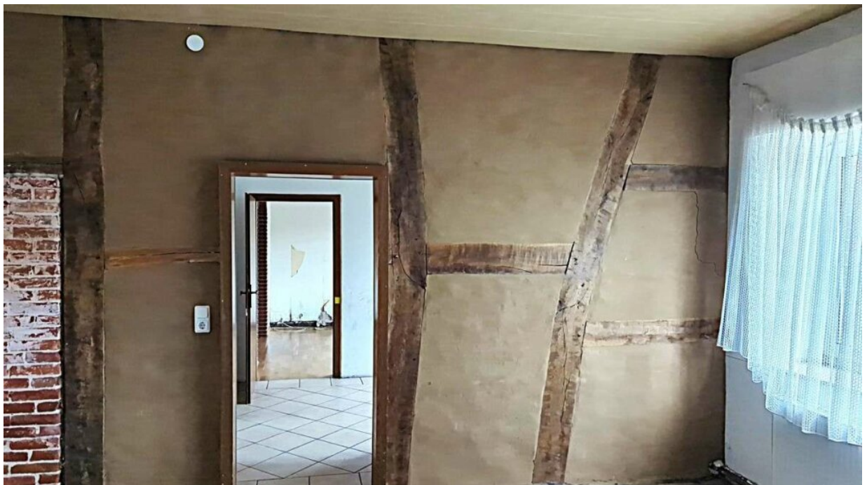
EG Wohnung freigelegtes Fachwe
