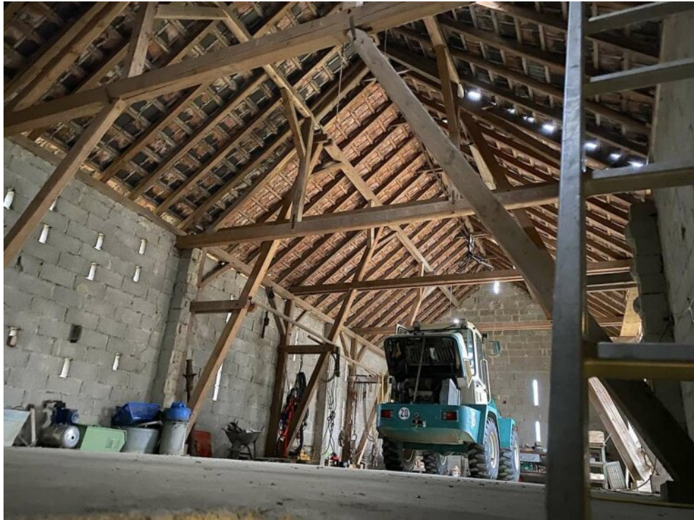
Dachboden ehemaliger Stall
