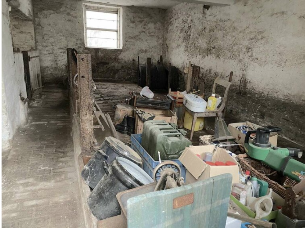
Raum I im Anbau
