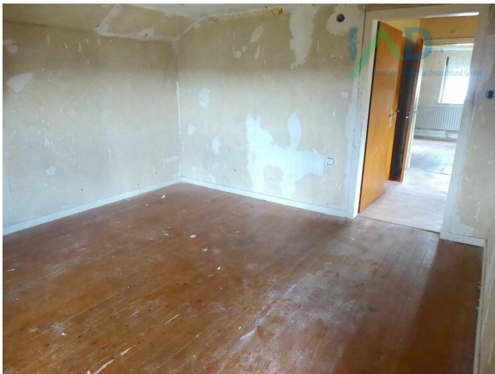
Durchgangszimmer II im OG
