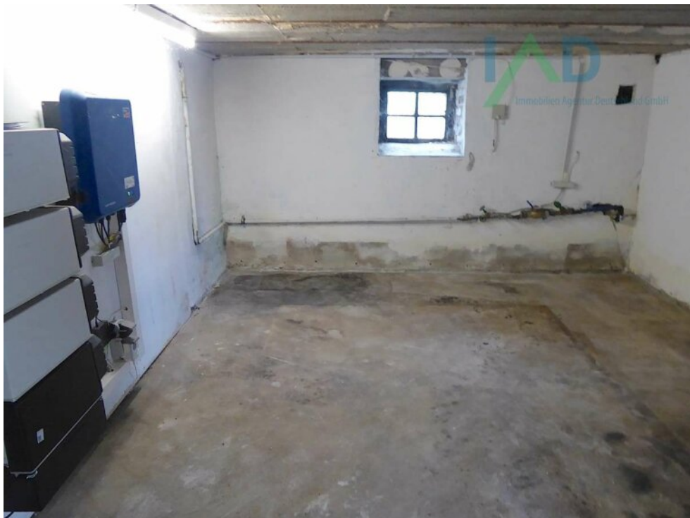
Kellerraum mit Anschluss Photo
