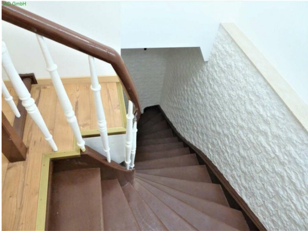
Holztreppe zum OG
