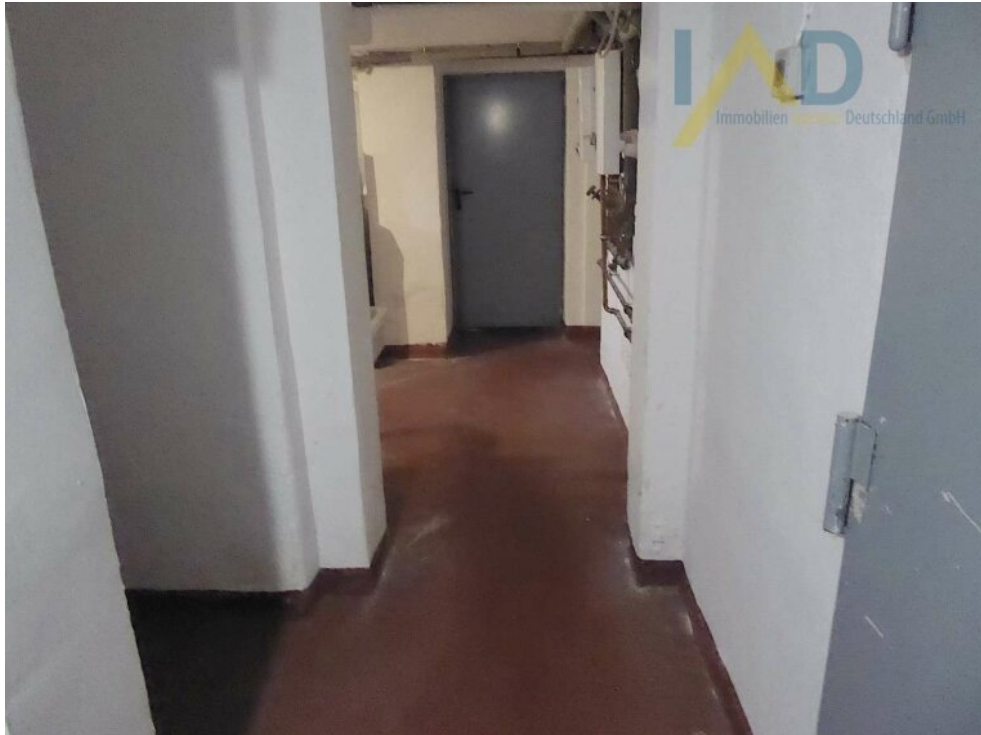
Flur im Keller
