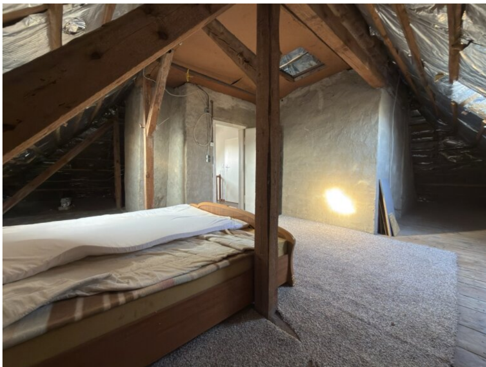
Nicht ausgebautes DG
