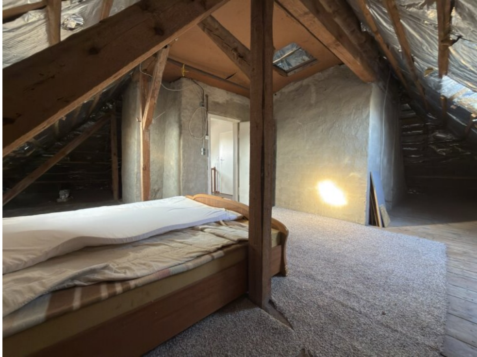
Nicht ausgebautes DG
